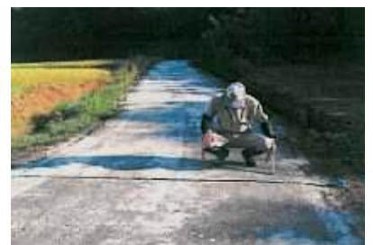
農道の砂利敷（再生アスファルト）
