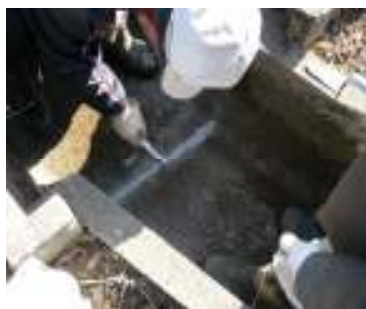
(柵の目地詰め)
