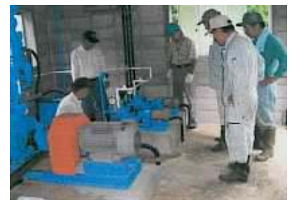
ポンプ室等施設点検・診断
